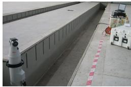
waren später die Messungen zum Ausrichten der Stahlkonstruktionen für die Transportplattformen. Zu den besonders herausfordernden Aufgaben des Projekts gehörte das Einmessen der Maschinenbetten, das Ausrichten der Schienenkonstruktion, der Abgleich der Transportsysteme sowie das Festlegen der exakten Punkte, an denen Rumpfteile und Flügel zusammengeführt
